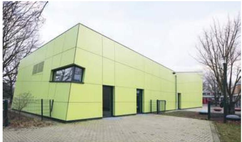
Der Baukörper besteht aus einer tragenden Skelettkonstruktion aus Stahl und Holz mit Aussteifungen und Trennwänden aus Stahlbeton und Mauerwerk. Die Fassade wurde als hinterlüftete Vorhangfassade und das Dach als extensives Gründach ausgeführt. Der Neubau der Mensa mit Passivhauskomponenten erhielt zudem eine Lüftungsanlage mit Wärmerückgewinnung für eine kontrollierte Be- und Entlüftung.
